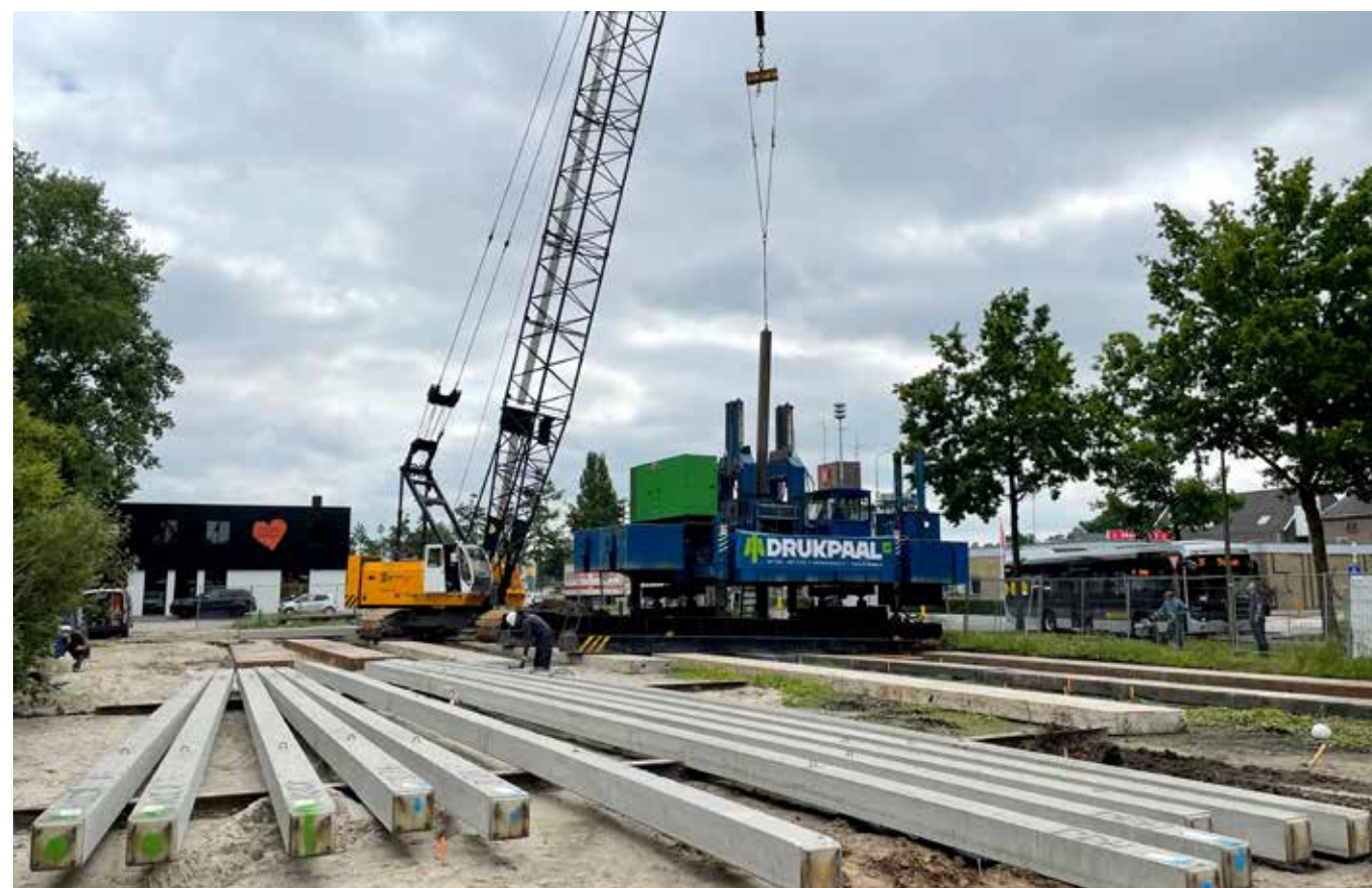
De Pile Pusher Pro heeft een laag brandstofverbruik en kan zelfs volledig elektrisch worden aangedreven. (Beeld ©Menrik Doombos, Drukpaal.nl)
